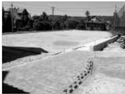
Prace przy boisku w Biertowicach fot. Dorota Gabryl
