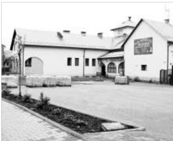
Plac przed strażnicą – remont już rozpoczęto. Fot. Monika Widlarz
